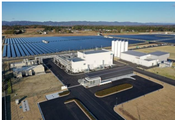
水素エネルギー ネットワーク (水素製造施設)
